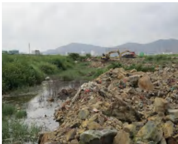
图 4.4-5 拟建场地北侧约 1180.m 处待建场地一带, 见有大量生活垃圾堆积, 堆积物附近水沟受污染, 镜向东南
