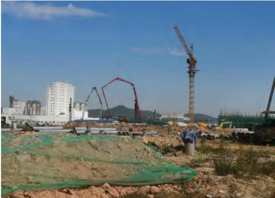
图 01-1 项目施工现场照片
